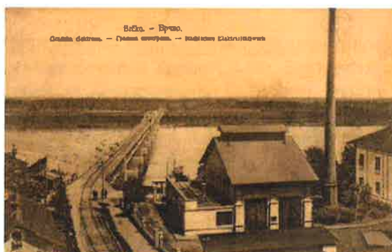
Прва градска електрана
